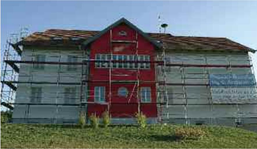
**Neue Hülle.** Die Fassade beim Feuerwehrhaus war stark von Algen befallen. Nachdem die Reinigung in Eigenregie durch die Feuerwehr nicht funktionierte, wird nun von der Firma Fassadenspezialist Ing. G. Angerer ein Neuanstrich vorgenommen. Besondere Konditionen der Firma und Arbeiten in Eigenregie machten das Projekt möglich.
