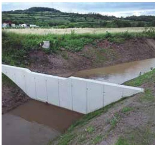
**Ein sinnvoller Schutz.** Die Kaskaden in der Annagasse haben sich bereits bewährt. Bei den letzten Gewittern mit Starkregen wurden die Regenwässer aus dem Gewerbegebiet aufgefangen und wie in einem Rückhaltebecken einer kontrollierten Versickerung zugeführt.
