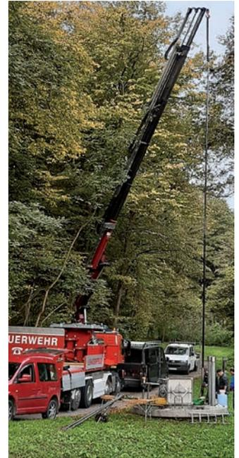
► *Bei einem Pumpenaustausch im Brunnenhaus Richtung Langenlois halfen alle zusammen, um den Austausch der kaputten Pumpe so rasch wie möglich vornehmen zu können. Der Kranlader bietet hier eine wichtige und schnelle Hilfestellung!*
